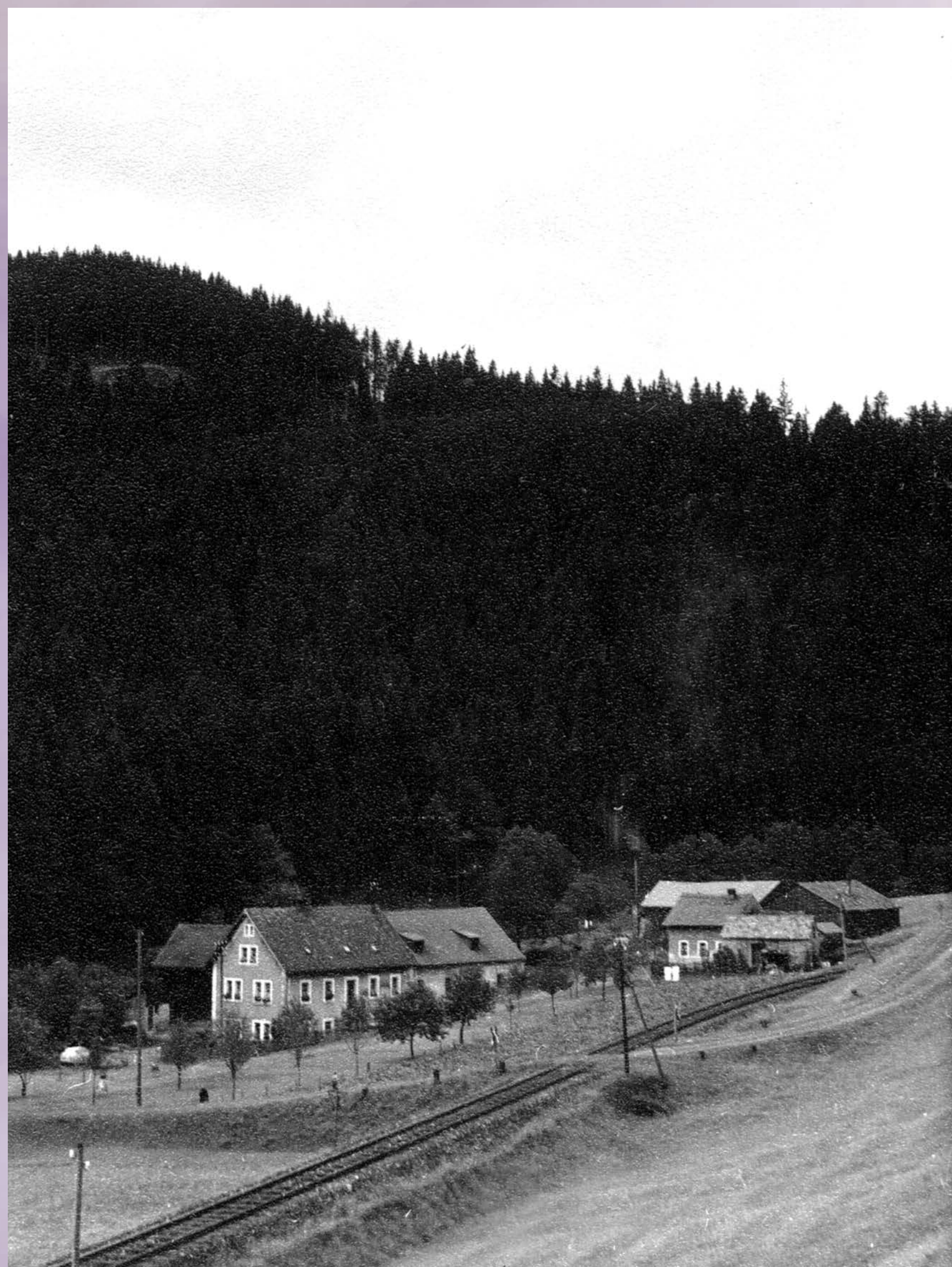
Rechts neben dem Wohnhaus befand sich die Schleiferei. Am rechten Bildrand ist unter anderem das kleine Gipshäuschen zu erkennen.
