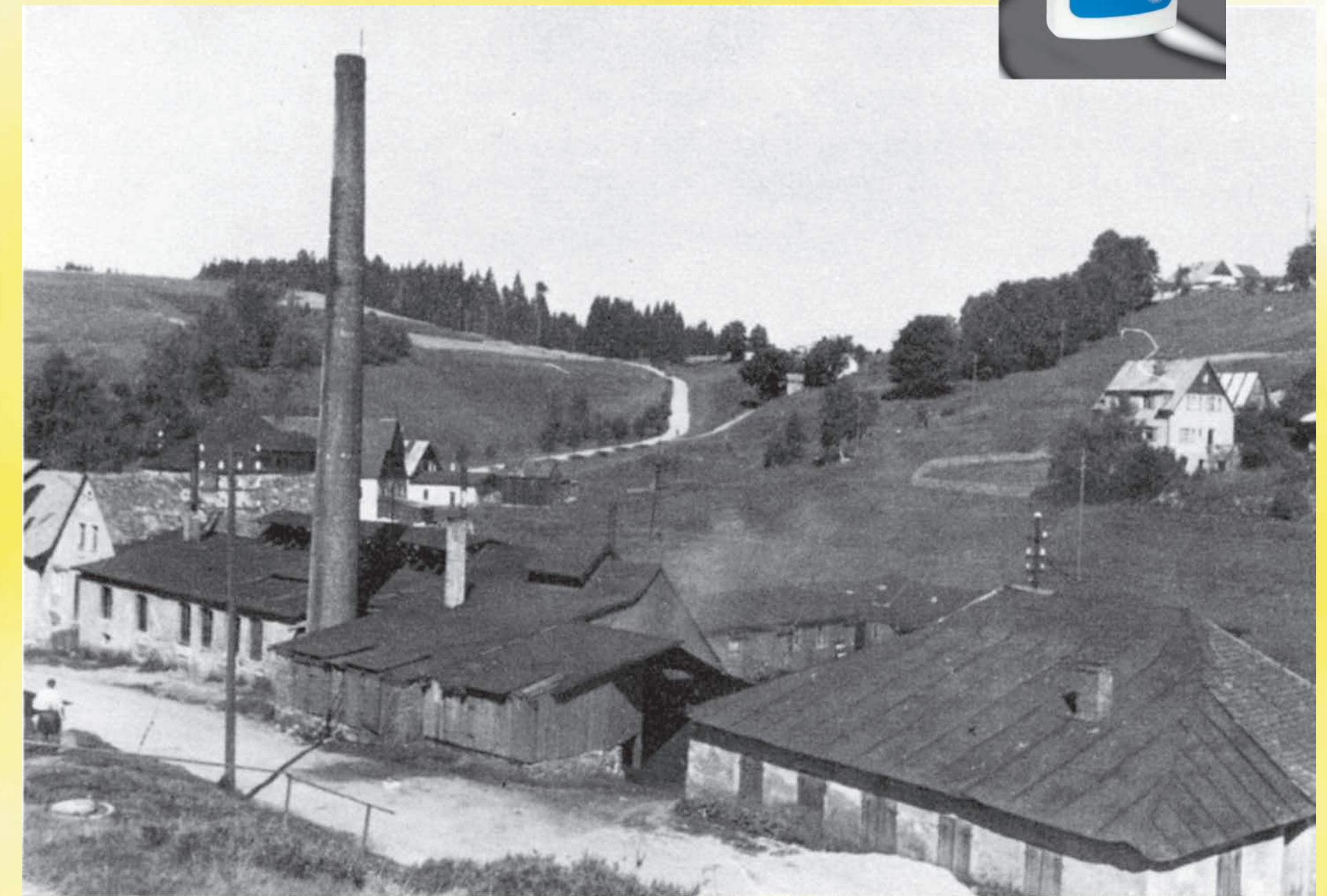
Das alte Hüttengebäude von der noch unbefestigten Staatsstraße her.
