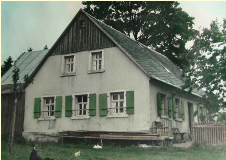
Wohnhaus Kaiser vor dem Umbau (Foto: Fritz Kaiser).
